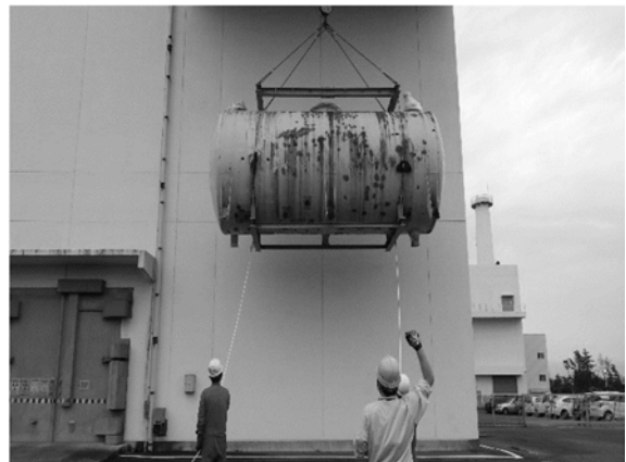
解体分別保管棟解体室への搬入
