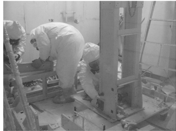
走行台車の解体②
