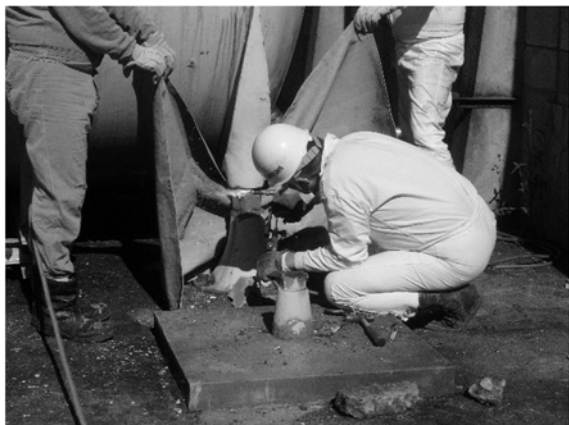
ガス溶断で脚部の切断
