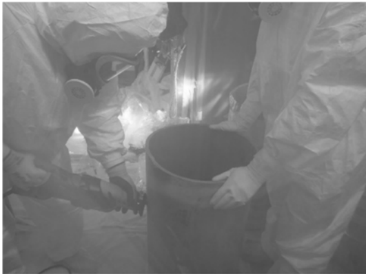
排気ダクトの細断状況
