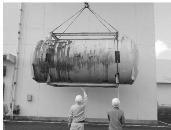
解体分別保管棟解体室への搬入
