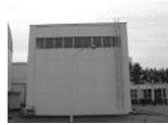
保障措置技術開発 試験室施設 (SGL)
