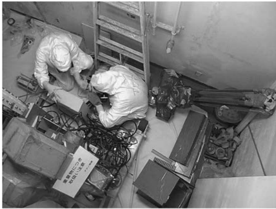
走行台車の解体①
