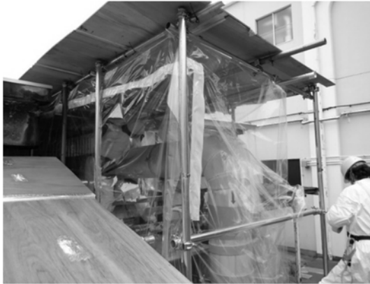
グリーンハウスの設置状況
