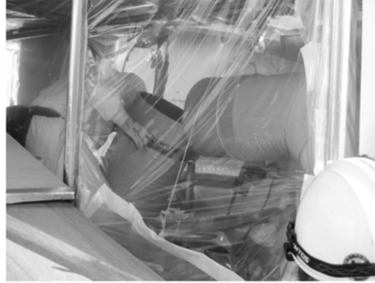
排気ダクトの切断作業状況
