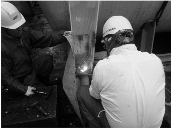
ガス溶断で脚部の切断
