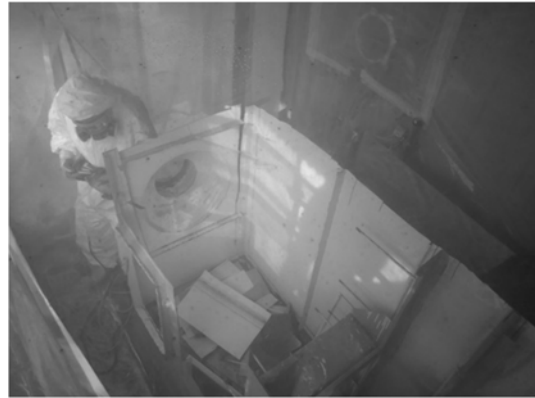
排気フィルタユニットの切断作業状況
